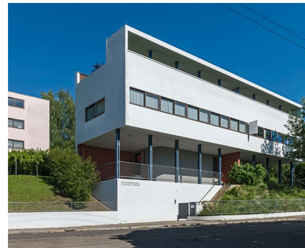
Das Gebäude, entworfen von Le Corbusier, beherbergt heute ein Museum über den Architekten und ist Teil des UNESCO-Welterbes „Das architektonische Werk von Le Corbusier“. Stuttgart, Weissenhofsiedlung, Weissenhofmuseum im Haus Le Corbusier, Foto: © Landesamt für Denkmalpflege im Regierungspräsidium Stuttgart/I. Geiger-Messner, Juli 2018
