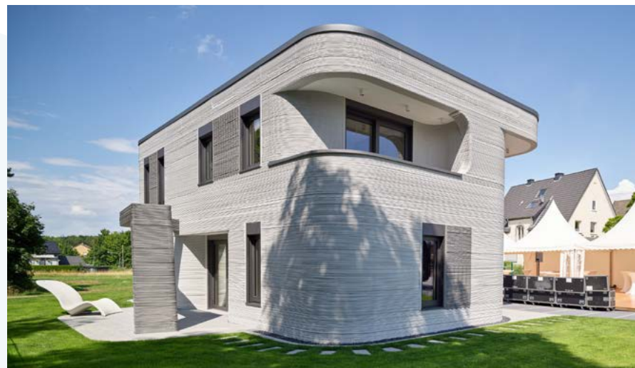
Wohnhaus Beckum. Foto: © Achim Reissner im Auftrag der PERI 3D Construction GmbH
