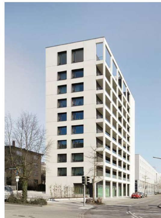
Vom neugeschossigen 1970er-Jahre-Wohnhaus zum zehngeschossigen Energieeffizienzhaus. Pforzheim, Energie-Effizienzhaus, Foto: © Dietmar Strauß, o. J.
