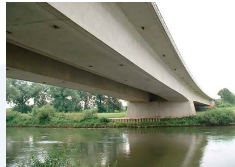
Abbildung 8: Brücke Donauwörth. Foto: © StBA Augsburg
