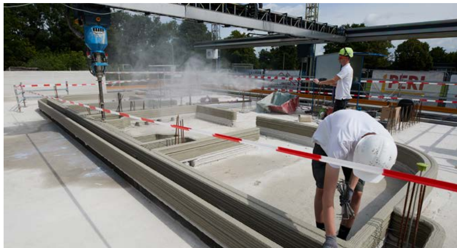
Errichtung des Vereinsheims in 3D-Betondruckweise in Nordkirchen. Foto: © Franklin Berger, MHKBD Nordrhein-Westfalen, 2023
