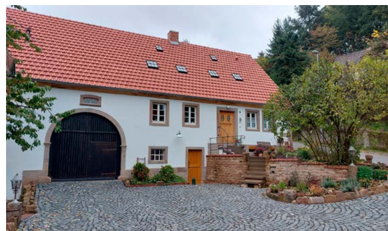
St. Wendel-Hoof, saniertes Bauernhaus. Foto: © Holger Neisius, 2022
