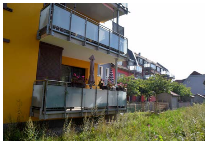
Nordhausen Schärfgasse rückseitig. Foto: © Steffen Groß
