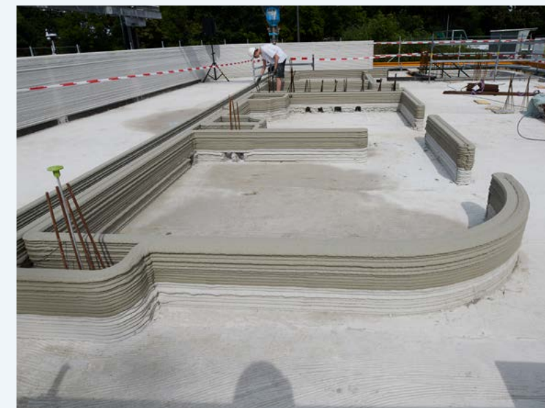
Errichtung des Vereinsheims in 3D-Betondruckweise in Nordkirchen. Foto: © Franklin Berger, MHKBD Nordrhein-Westfalen, 2023
