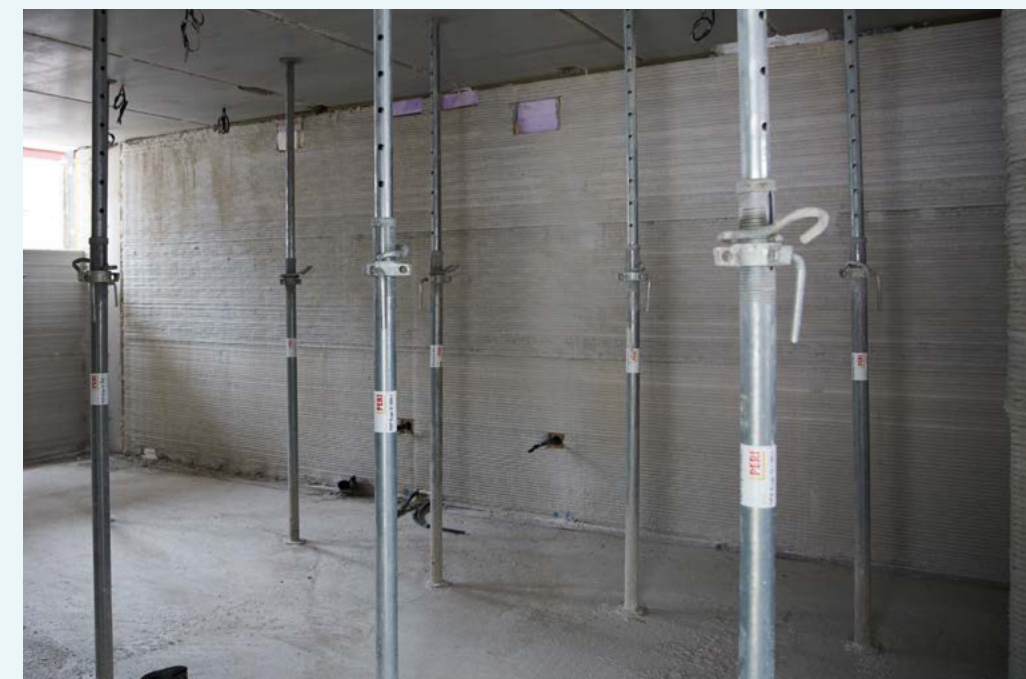
Errichtung des Vereinsheims in 3D-Betondruckweise in Nordkirchen. Foto: © Franklin Berger, MHKBD Nordrhein-Westfalen, 2023
