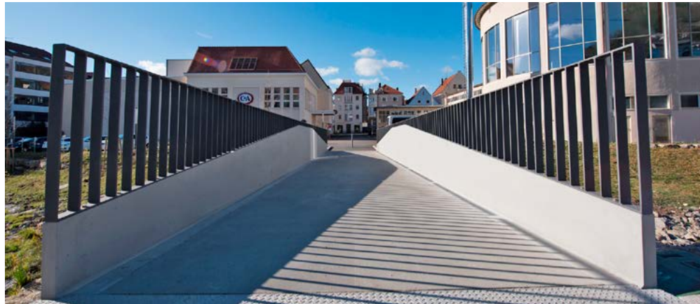
Abbildung 9: Erste Fuß- und Radwegbrücke aus Carbonbeton in Albstadt-Ebingen. Foto: © solidian
