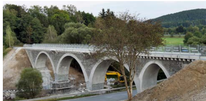
Abbildung 6: Historische Betonbogenbrücke in Naila nach der Verstärkung mit Carbonbeton. Foto: © Stefan Gröschel
