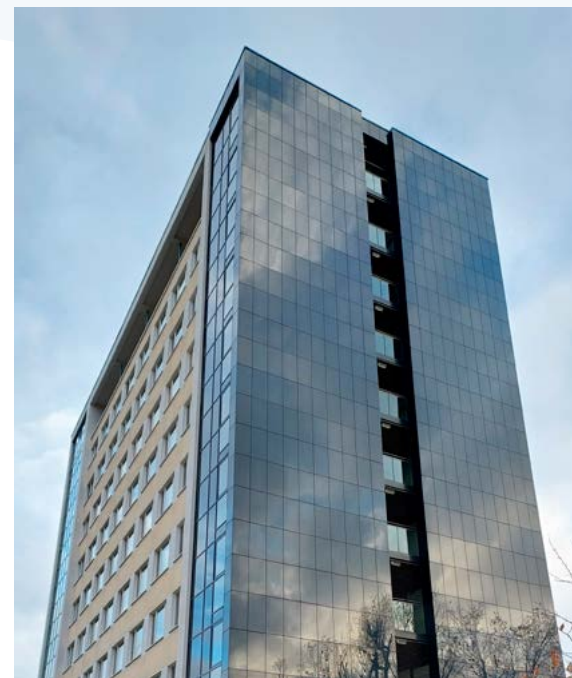
Universität Erfurt, Mitarbeitergebäude 1. Foto: © Mathias Heller
