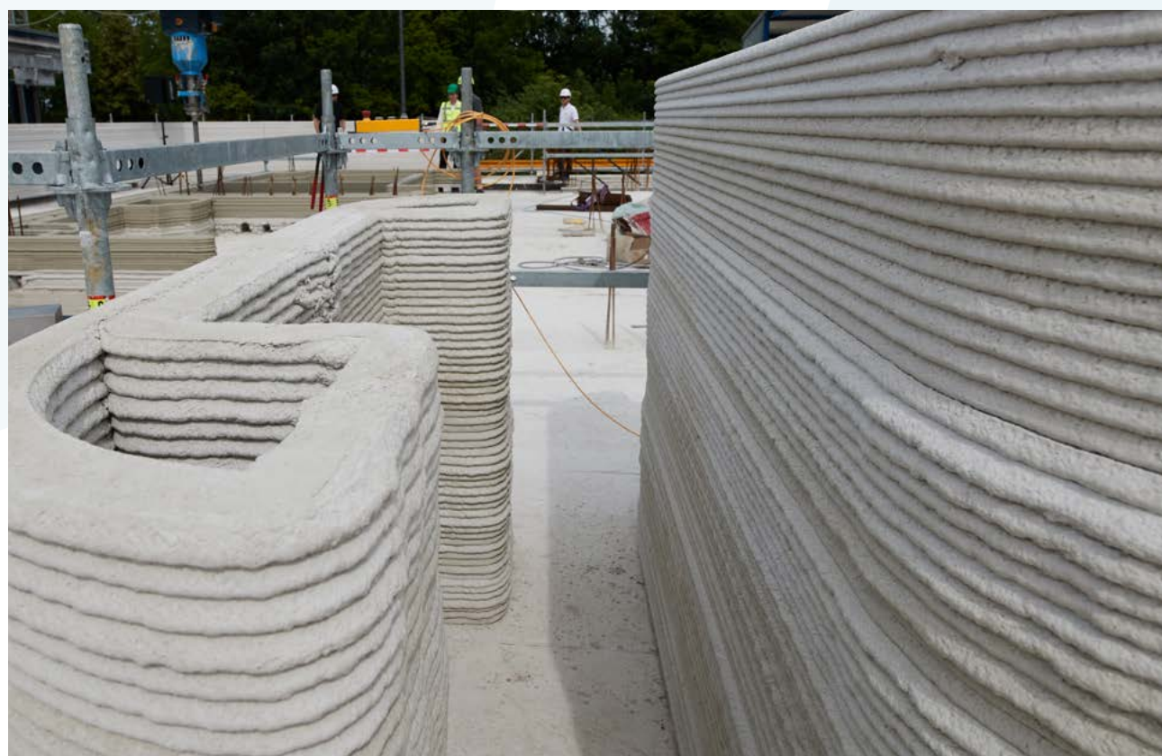
Errichtung des Vereinsheims in 3D-Betondruckweise in Nordkirchen. Foto: © Franklin Berger, MHKBD Nordrhein-Westfalen, 2023
