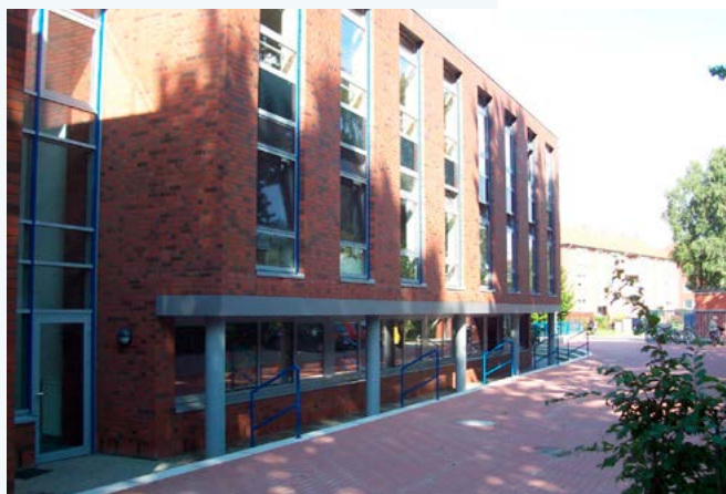
Stadt Emden, Sanierung. Foto: © Stadt Emden, 2004
