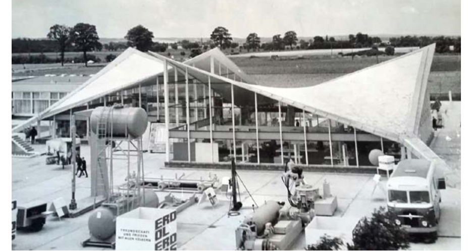
Messepavillon Rostock-Schutow historisch. Foto: © Müther-Archiv Wismar
