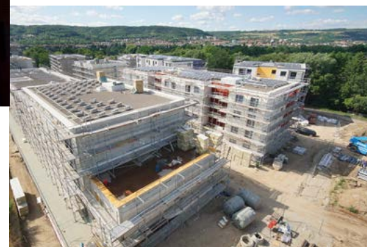
Baustelle „Erlenhöfe im Stadtteil Wenigenjena“. Foto: © WG Carl Zeiss eG/ Goldbeck Webcam Erlenhöfe
