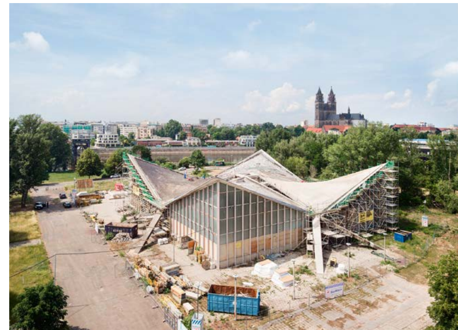
Abbildung 4: Verstärkungsarbeiten mit Carbonbeton an der Hyparschale in Magdeburg. Foto: © M. Bredt
