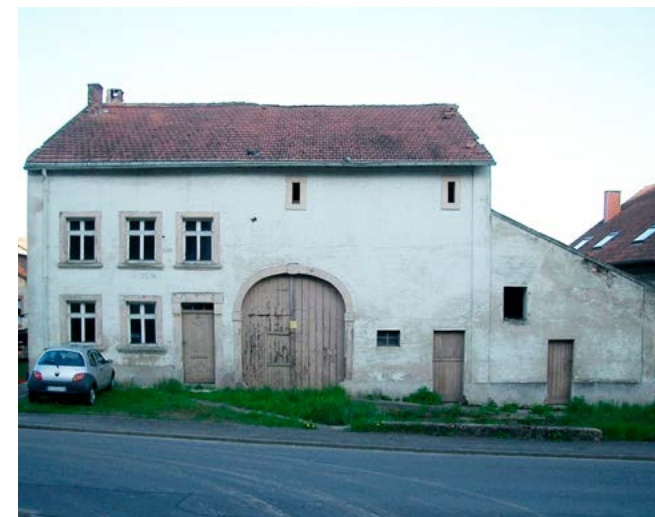
Stilgerechte Sanierung Lothringer Einhaus in Merzig-Mechern (vorher). Foto: © Prof. Dr. Heinz Quasten
