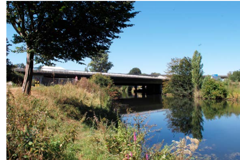
Abbildung 7: Autobahnbrücke über die Nidda bei Frankfurt am Main, Deutschland. Foto: © Oliver Steinbock
