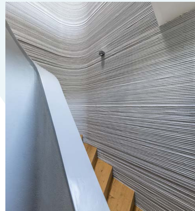
Wohnhaus Beckum. Foto: © Achim Reissner im Auftrag der PERI 3D Construction GmbH
