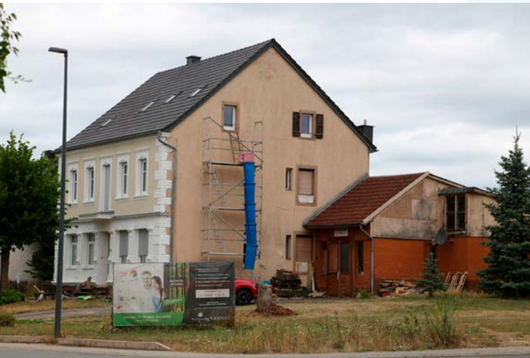
Gemeinde Lockweiler, Sanierung Wohnhaus und Schreinereiwerkstatt von 1910. Foto: © Sandra Koch-Wagner, 2023
