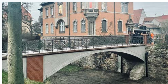
Abbildung 5: Ansicht der historischen Bogenbrücke Thainburg; oben: vor der Verstärkung; unten: nach der Verstärkung mit Carbonbeton. Fotos: © CARBOCON GMBH
