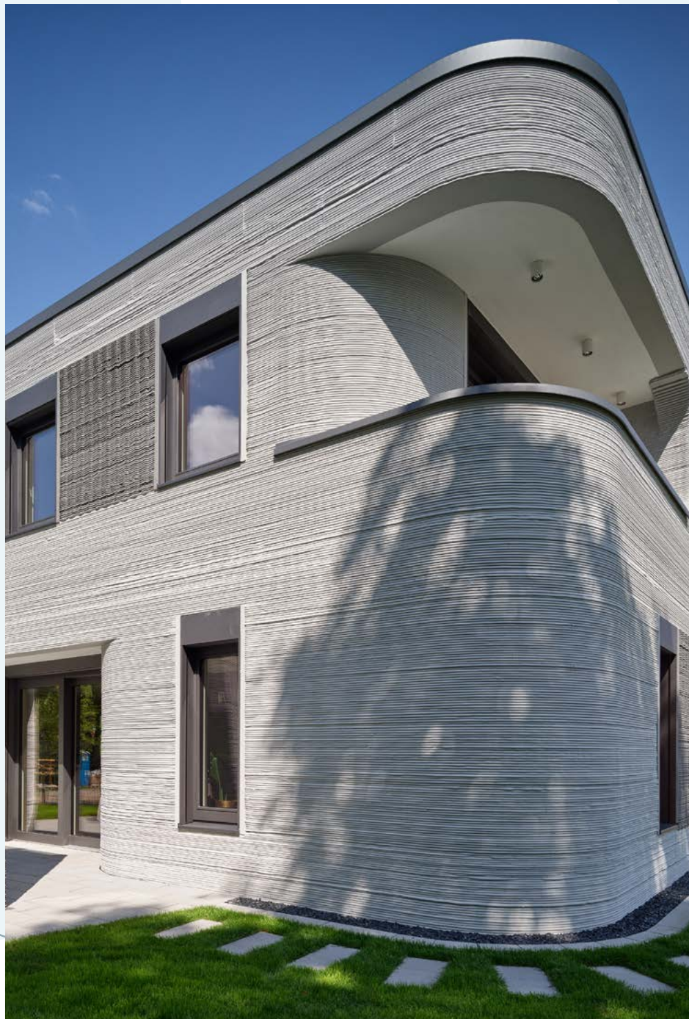
Wohnhaus Beckum. Foto: © Achim Reissner im Auftrag der PERI 3D Construction GmbH
