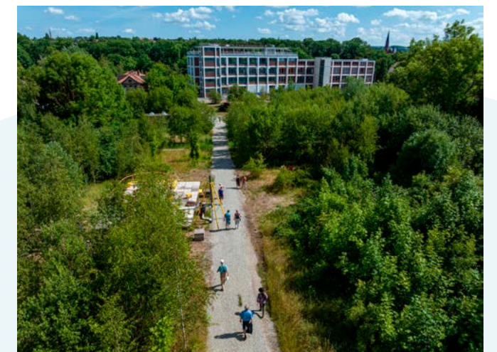
Foto nach Fertigstellung des Eiermannbaus in Apolda. © IBA Thüringen, Foto: Thomas Müller
